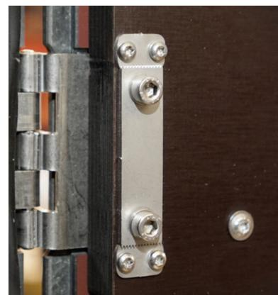
Der Abstand der Tür wird verändert, indem die Anschraubplatte nochmal gelockert wird und zunächst um eine Zacke versetzt wird. Dies kann wiederholt werden bis der Türabstand passt. Danach kann auch die zweite Gewindeschraube angezogen werden.
