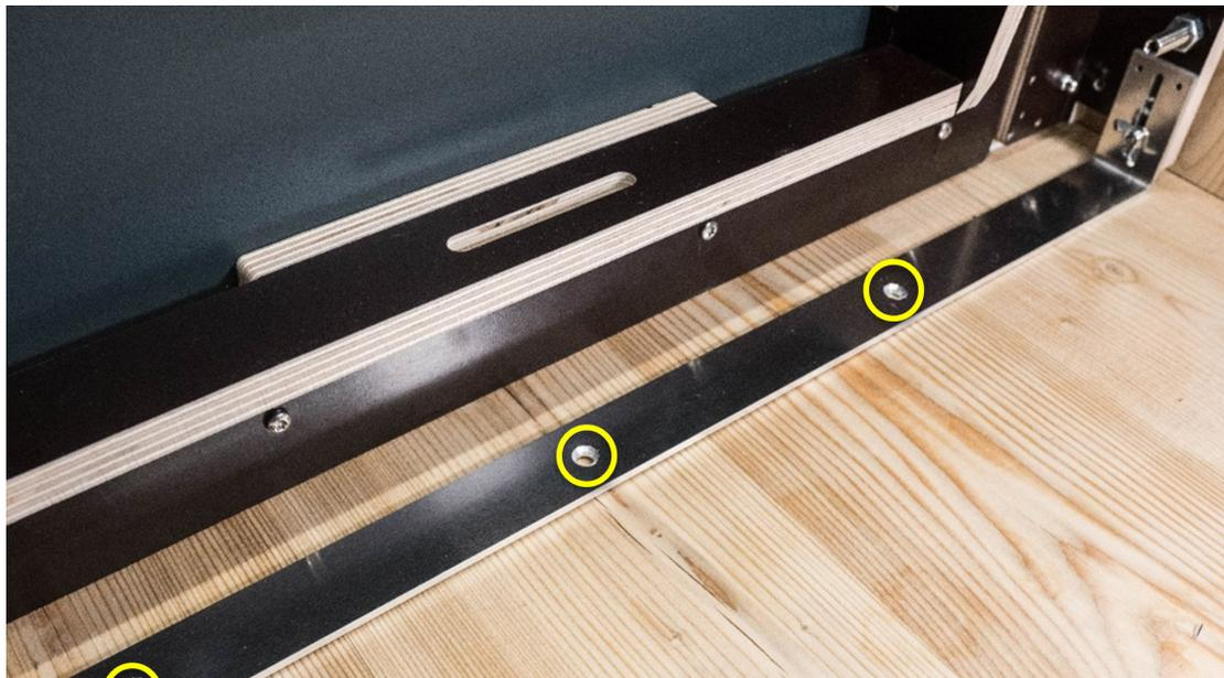
*Detailansicht der Löcher für die Befestigung am Boden durch den Metallfuß. Hier sollen Senkkopfschrauben verwendet werden (5x50mm Edelstahlschraube)*
