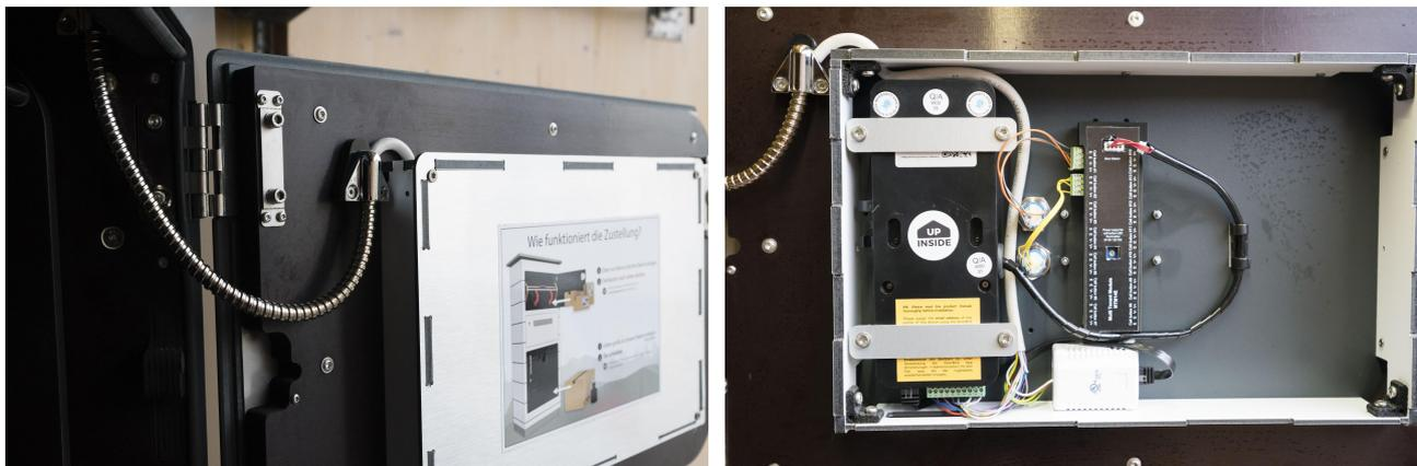
Damit Sie Ihre Kabel bequem anschließen können, verlegen wir alle Eingänge der Doorbird in den rechten Zwischenraum der Seitenwand. Hier schließen Sie Ihr Strom-Kabel, LAN-Kabel oder Ihren Klingeldraht an.
